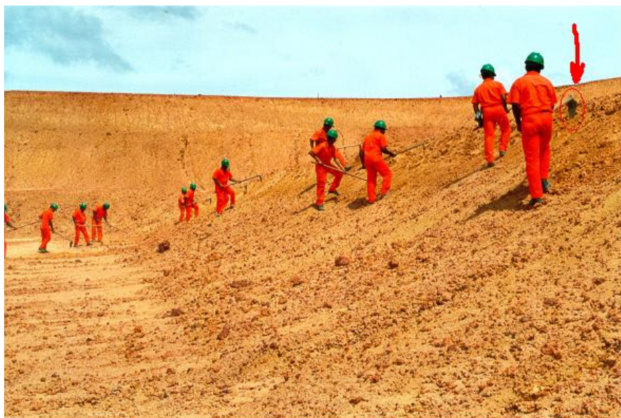
Foto 1: Preparo manual do terreno para aplicação de hidrosemeadura em área degradada.
