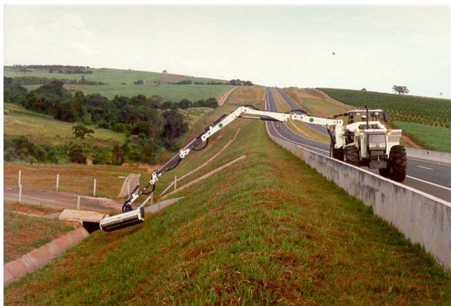
Foto 7: Vista frontal de equipamento realizando poda de talude em rodovia.
