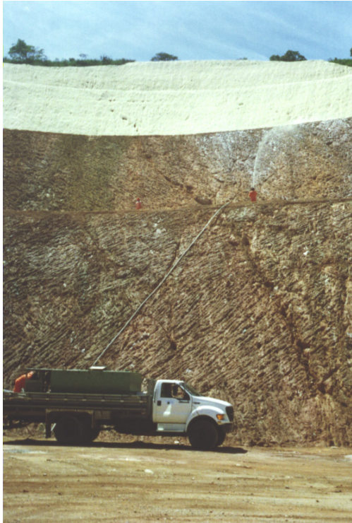
Foto 2: Caminhão de hidrosemeadura e aplicação da mistura em taludes de corte em áreas degradadas.
