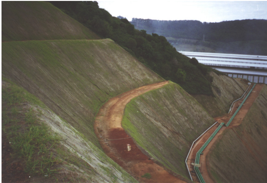
Foto 5: Taludes já revegetados através de hidrosemeadura.
