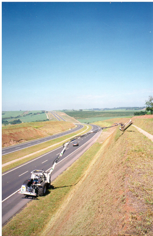
Foto 6: Poda mecanizada de taludes em rodovia através de trator com implemento hidráulico
