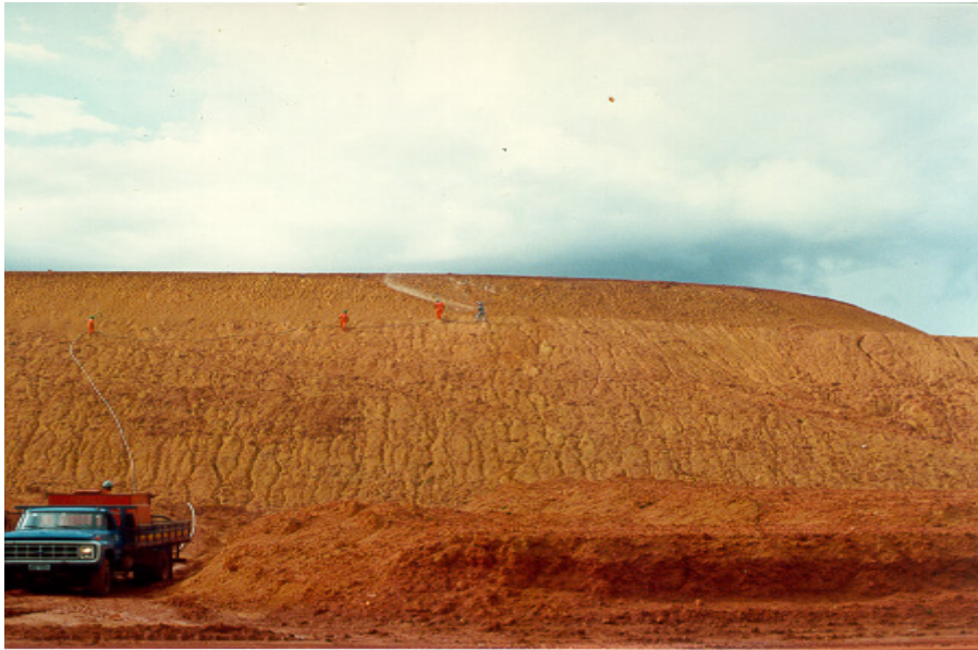
Foto 4: Aplicação de hidrosemeadura em área degradada
