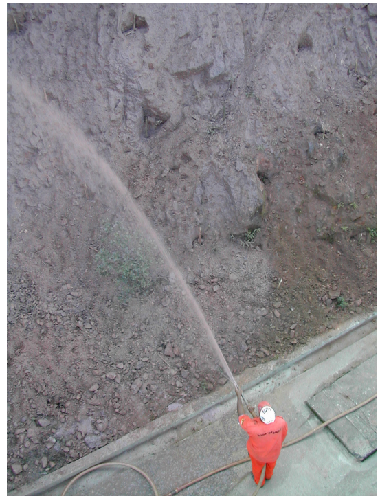
Foto 3: Aplicação da mistura em área de talude já escarificado.
