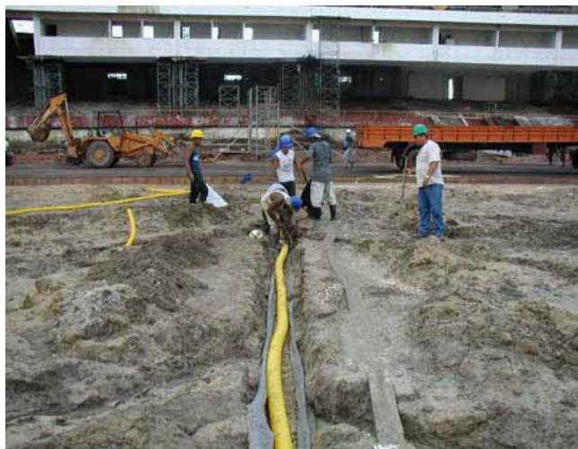
Figura 6: Colocação dos tubos corrugados durante a implantação dos tubos corrugados.
