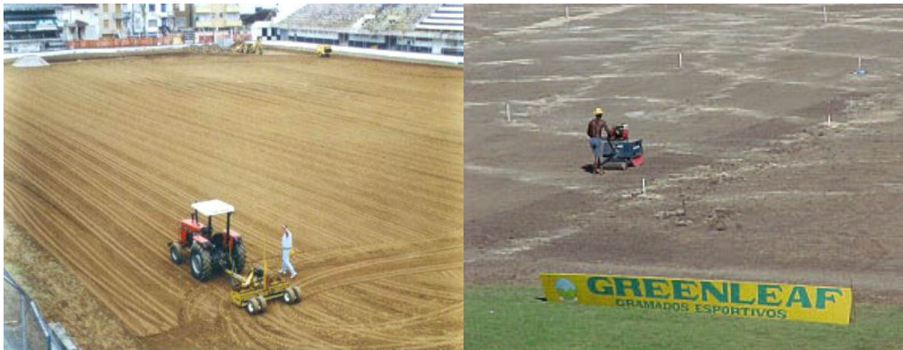
Figuras 12 e 13: Operações de compactação e nivelamento final.
