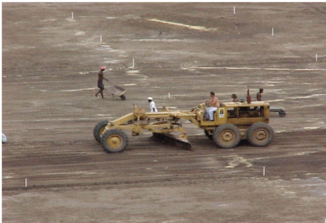
Figura 4: Nivelamento do terreno base, após levantamento planialtimétrico.
