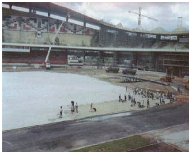
Figuras 8 e 9: Colocação do Top- Soil durante a implantação de gramados esportivos.
