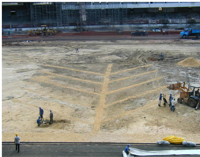
Figura 5: Implantação de um sistema de drenagem em espinha de peixe.
