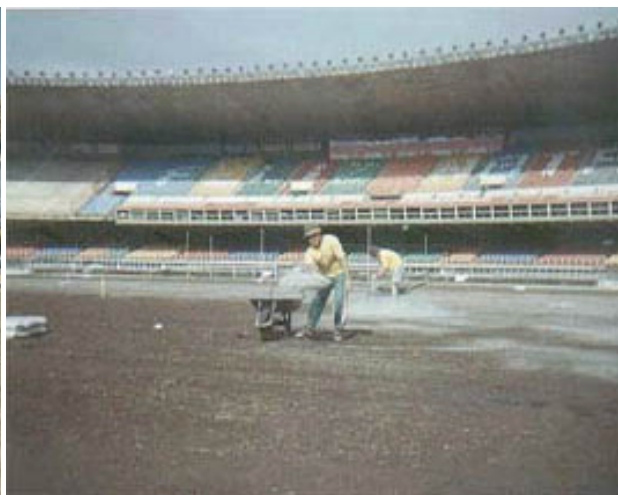
Figuras 10 e 11: Aplicação de corretivos e fertilizantes no pré-plantio do gramado.
