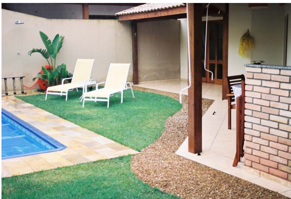
Figura 5. Captação de água pluvial integrada ao paisagismo.
