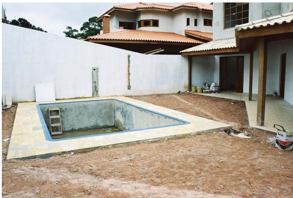
Figura 4. Área com necessidade de captador de águas pluviais.
