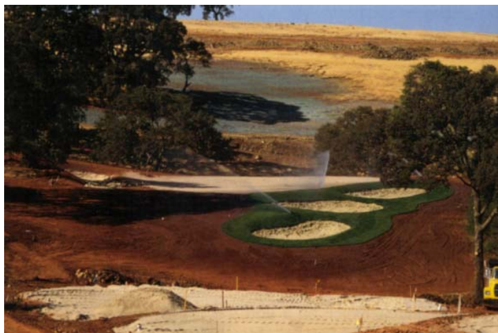
Figura 5. Realização da fertirrigação ao redor de alguns bancos de areia em um campo de golfe em implantação garantindo o pegamento do gramado sem a necessidade do tráfego de máquinas ou pisoteio por pessoas.
