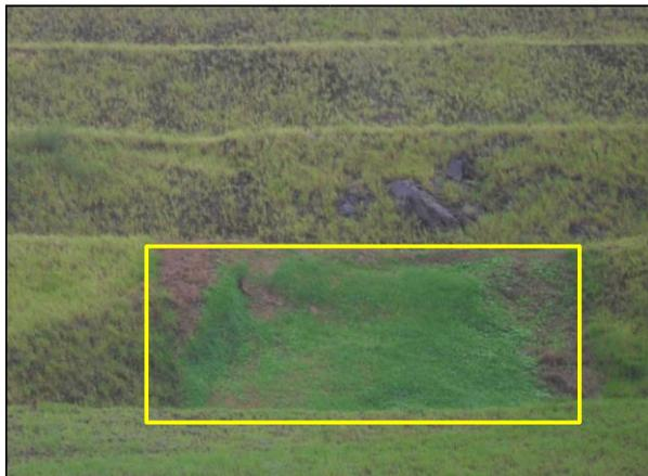
**Figura 1.** Resultado de aplicação de hidrossemeadura em talude após ocorrência de deslizamento.
