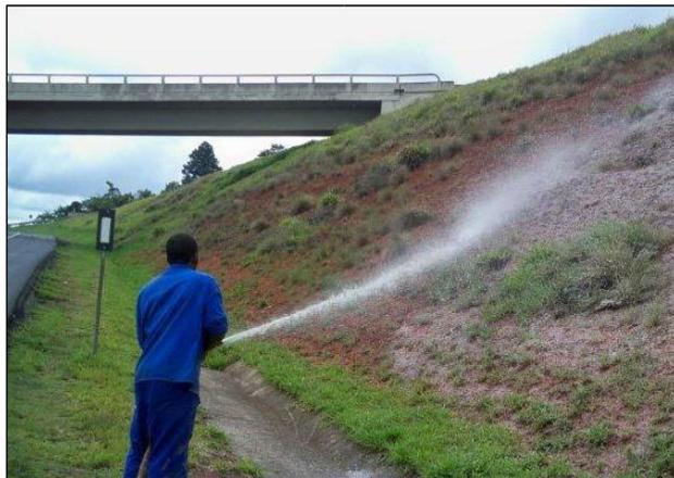
**Figura 2.** Aplicação de hidrossemeadura em talude.
