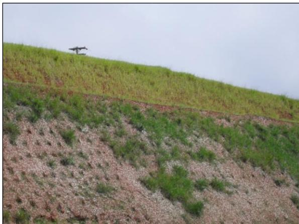
**Figura 3.** Aparência após aplicação de hidrossemeadura em talude.
