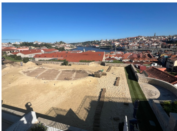
Figura 5. Tapete grama (instalação)
