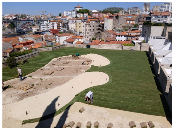
Figura 6. Tapete grama (instalação)
